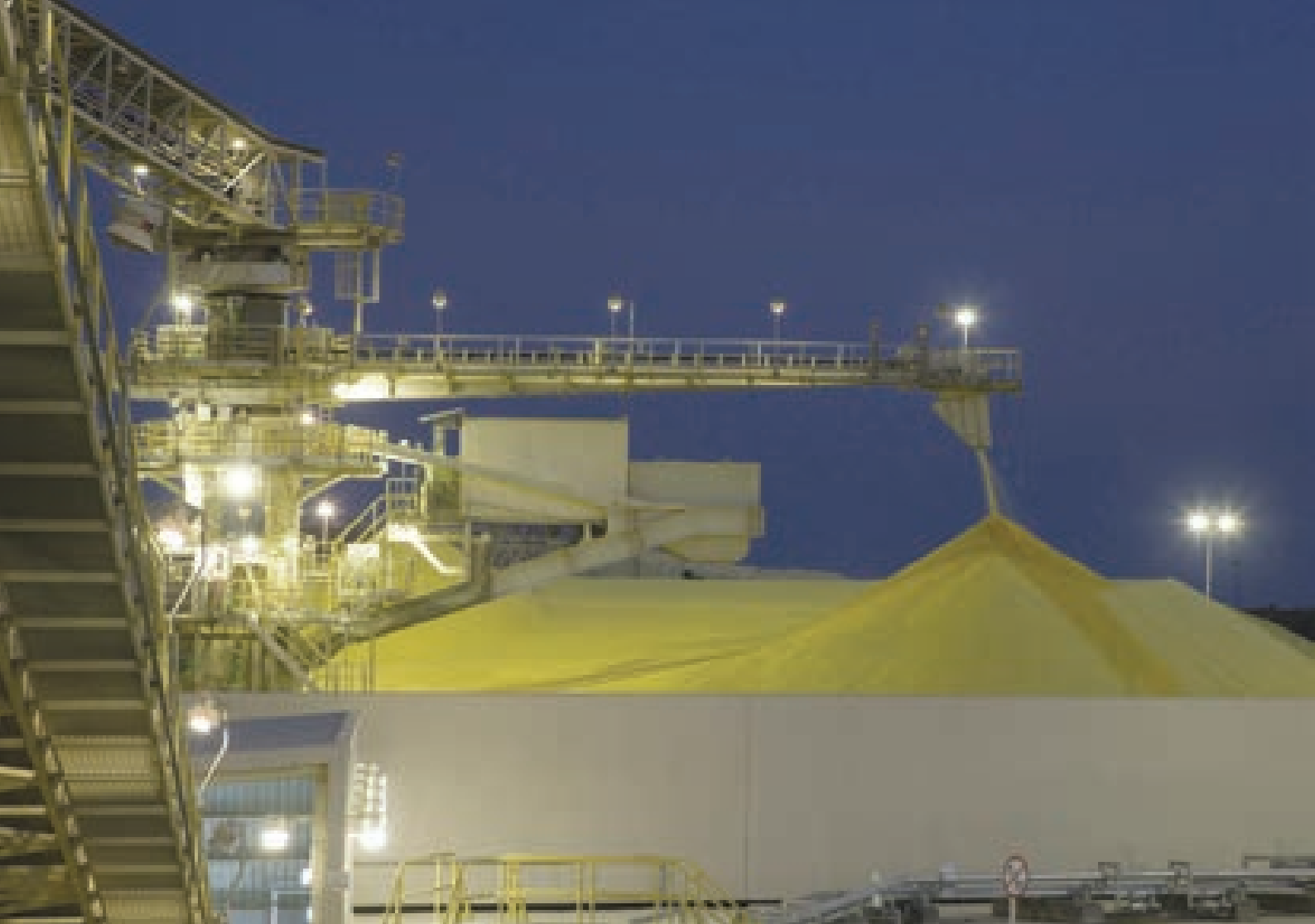
Насыпной резервуар – 30 000 тон
